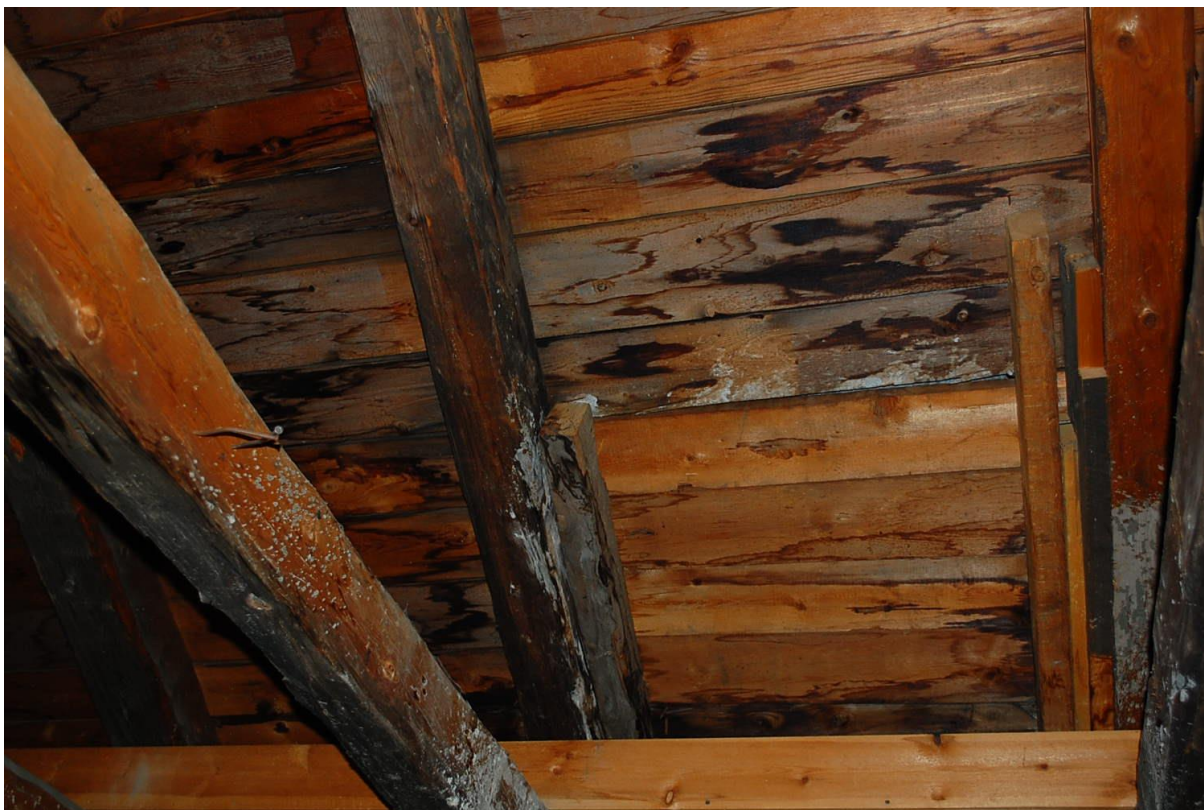
Kuva 31 Saumavuotojälkiä laudoituksessa
