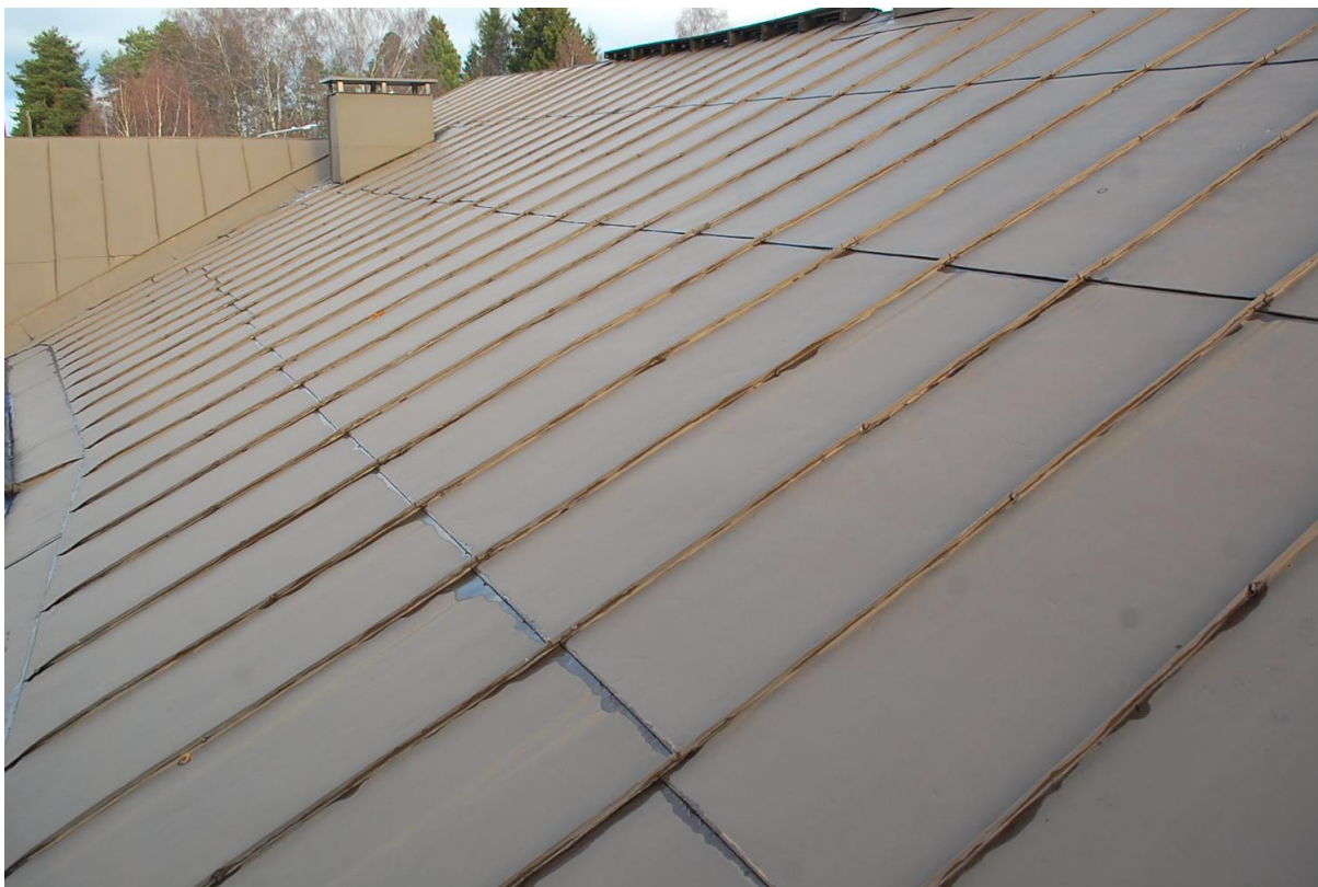
Kuva 11 Yleisnäkymä etusivun lappeen maalipinnoitteesta
