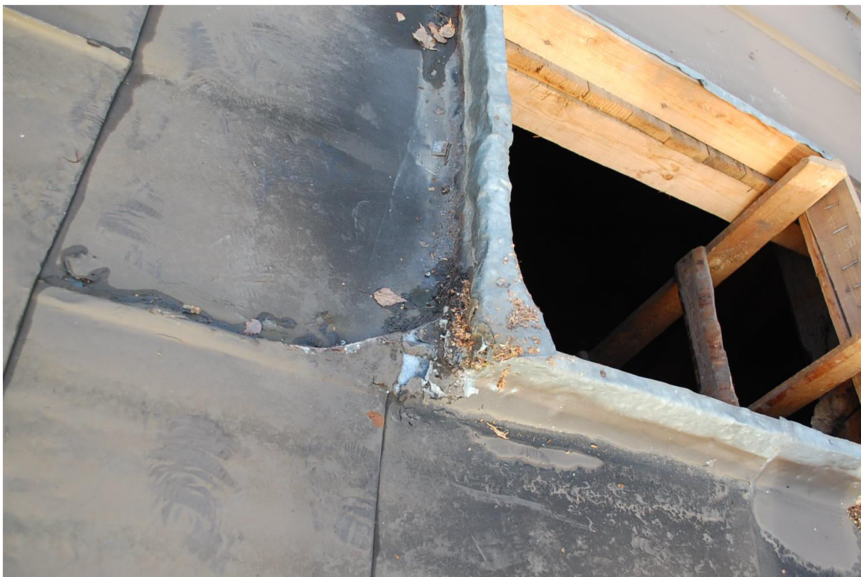
Kuva 21 Luukun kehyksen pellitys
