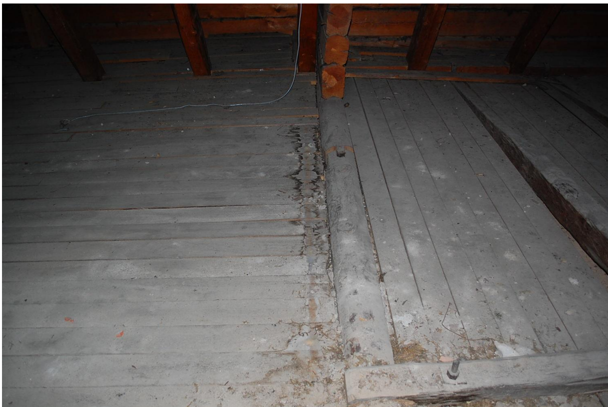
Kuva 33 Tippumisjätkirivi laualattialla
