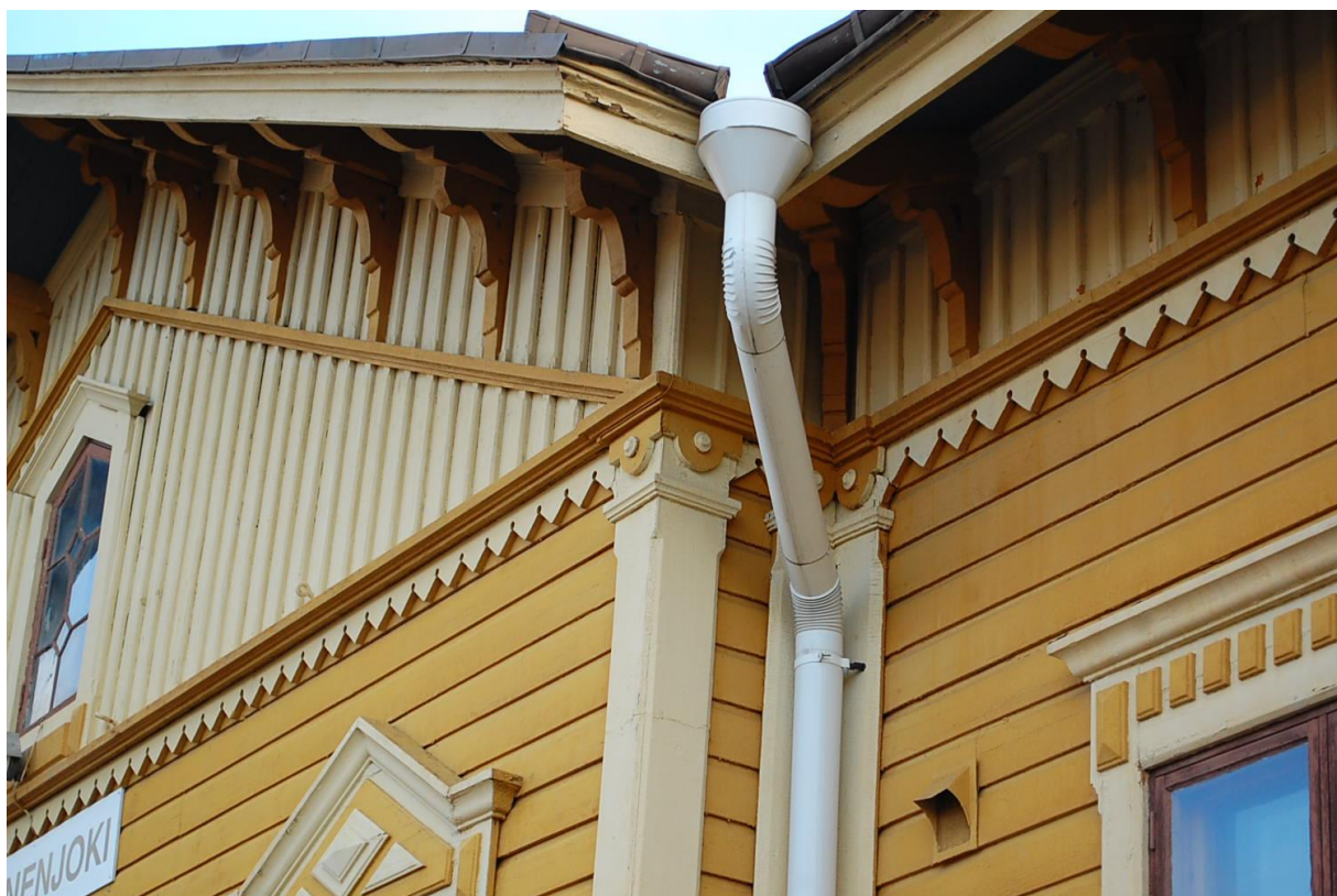
Kuva 42 Syöksytorvi
