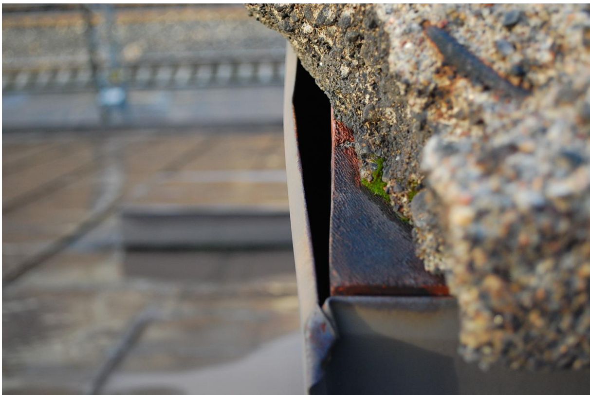
Kuva 16 Lohkeama piipun betonikakun kulmassa
