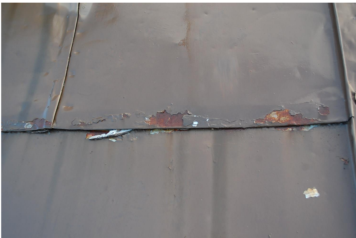
Kuva 14 Ruostetta poikkisaumassa
