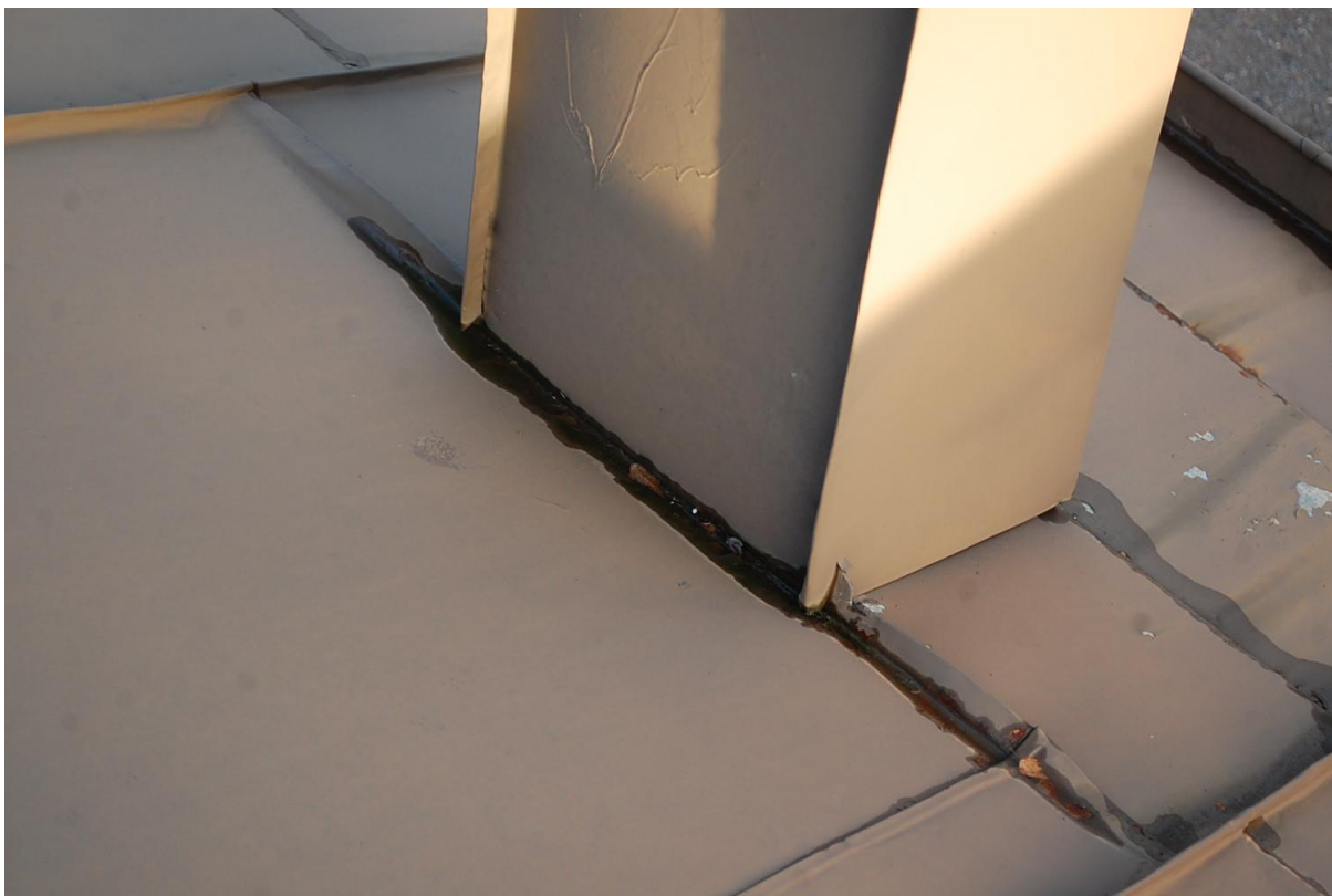
Kuva 17 Taustakaato puuttuu juuripellyksestä
