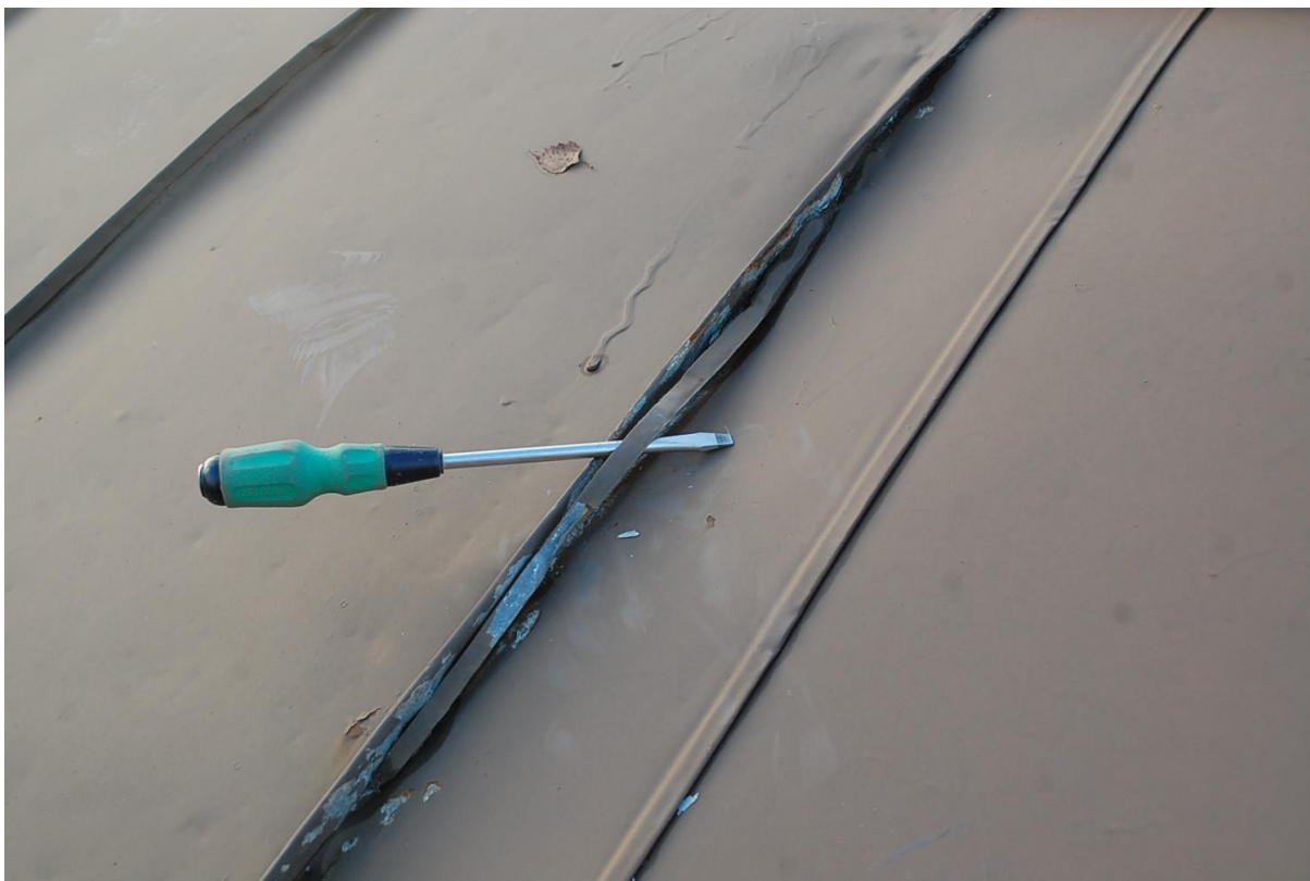
Kuva 3 Aiemman korjauksen yhteydessä ratkennut saumapelti
