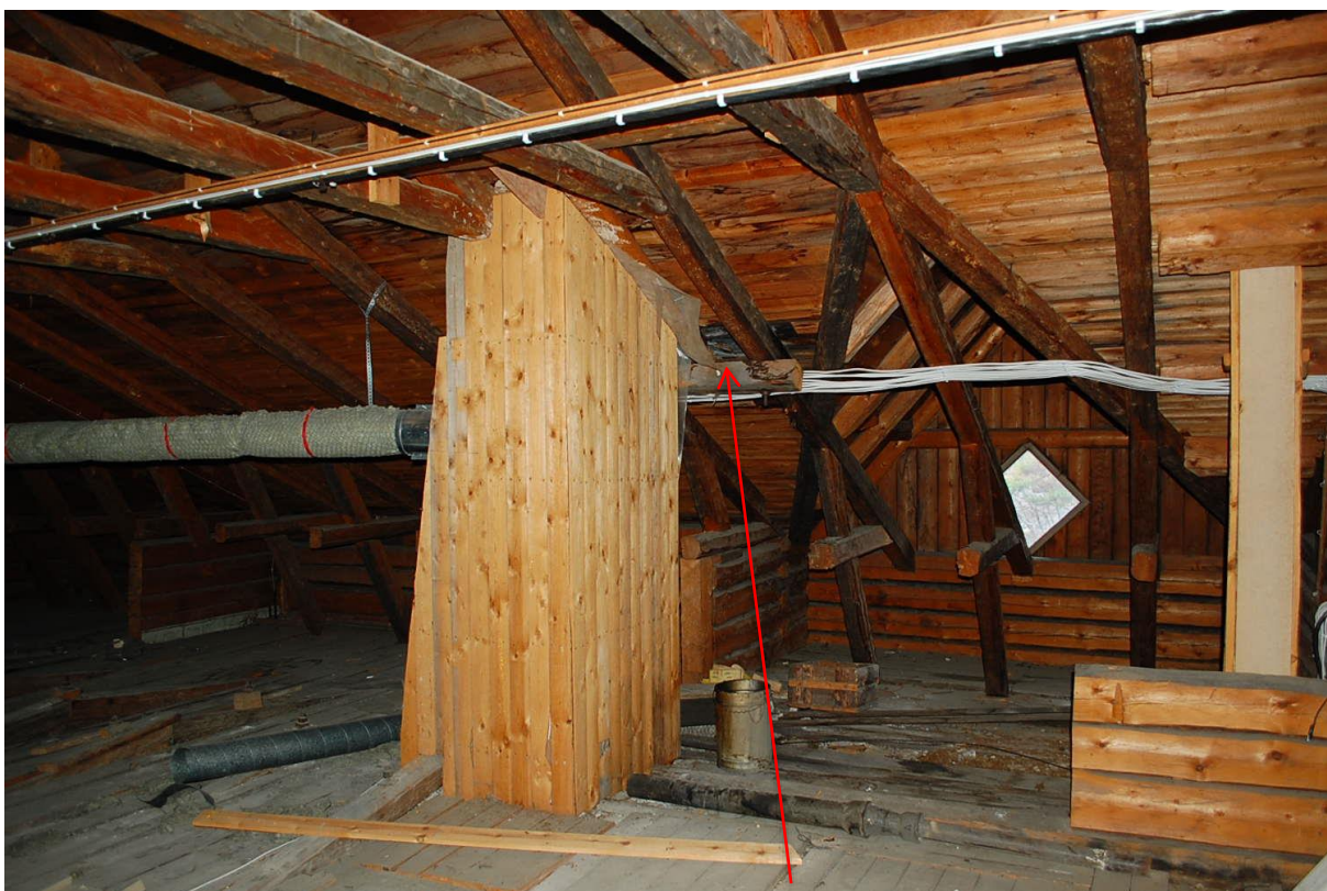
Kuva 8 Korjauspellityksen sijainti alapuolelta
