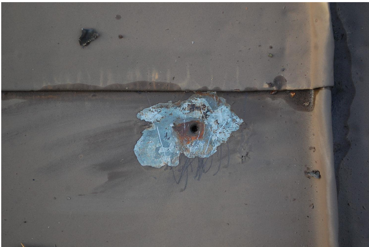
Kuva 5 Reikä peltirivissä
