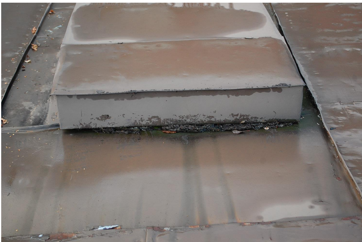
Kuva 22 Puutteellinen tuuletusväli
