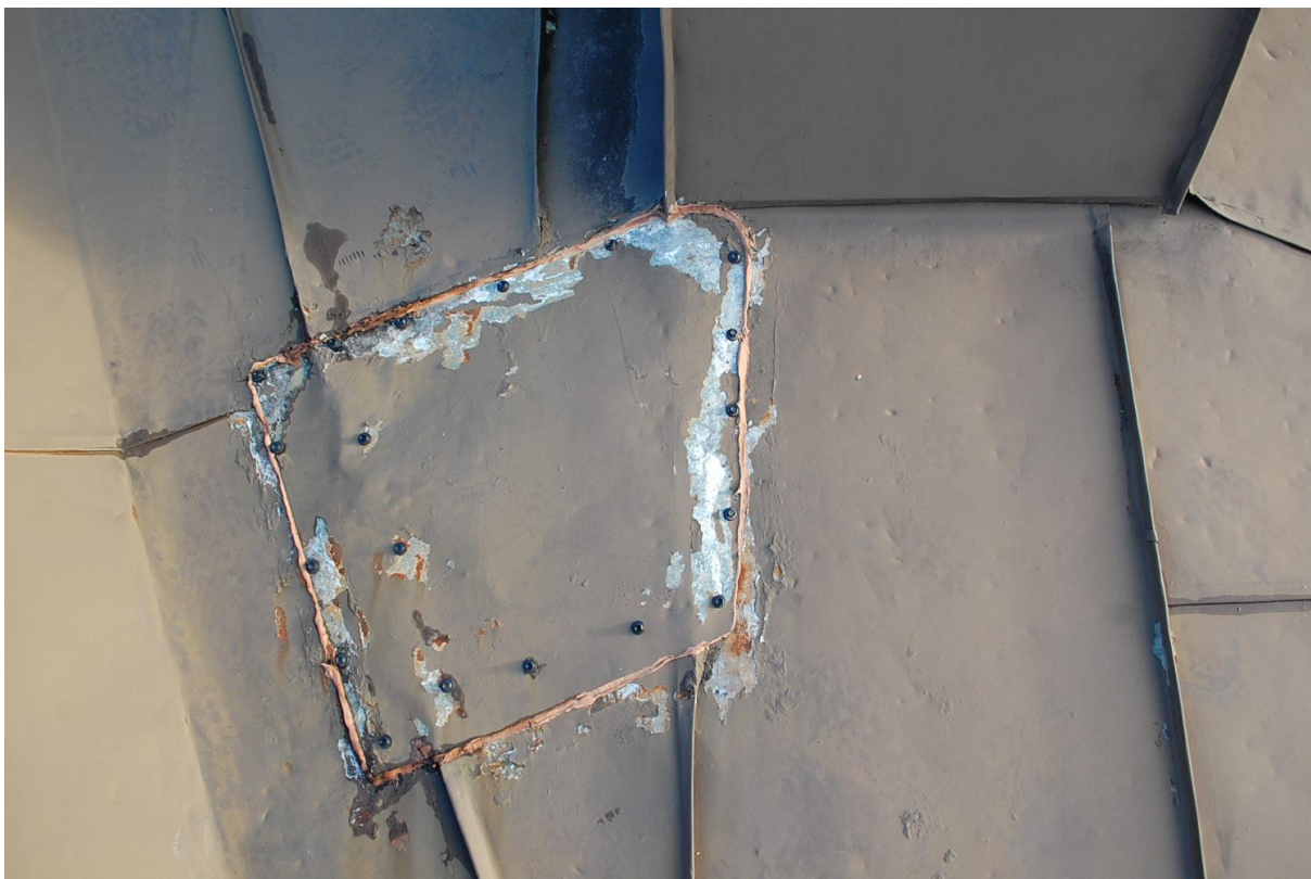
Kuva 7 Kateruuveilla kiinnitetty, saumojen päälle asennettu paikkalevy
