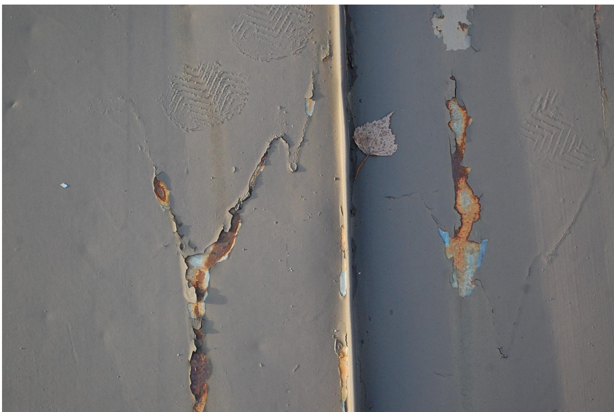
Kuva 12 Maalipinnoitevaurioita
