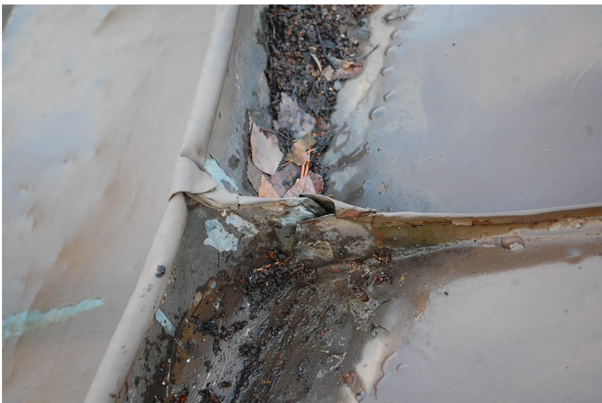
Kuva 40 Etusivun pystykourun liitos
