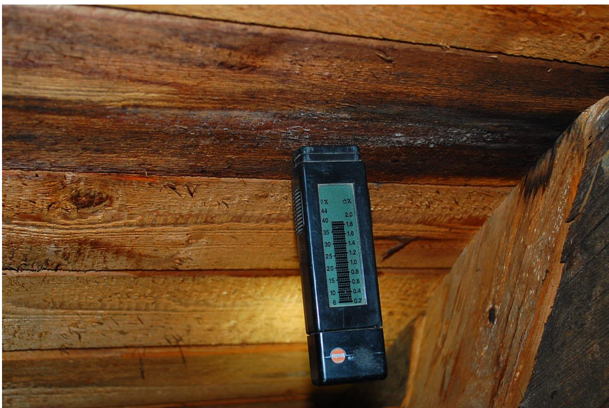
Kuva 32 Kosteusmittaus saumavuotojen kohdalta 39 p%
