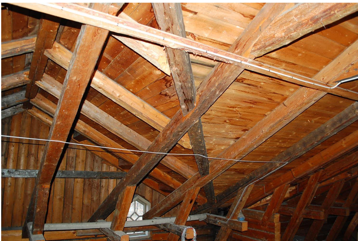
Kuva 30 Katteen aluslaudoitusta jjiirin kohdalta
