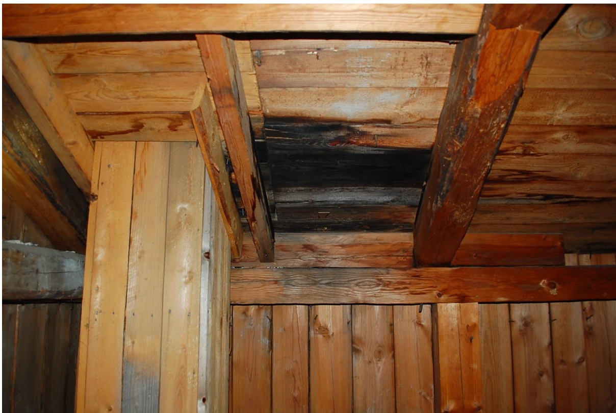
Kuva 18 Vuotojäljet edellisen kuvan läpiviennin alapuolella
