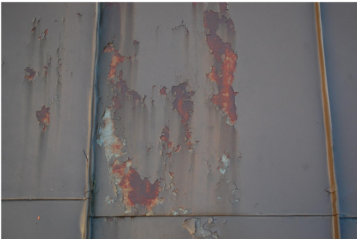
Kuva 13 Ruostetta peltiriveissä
