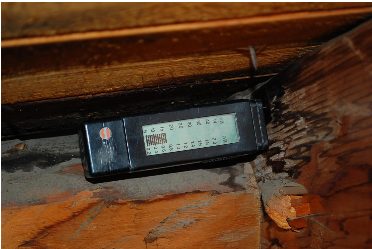
Kuva 35 Kosteusmittaus tulos 16 p%
