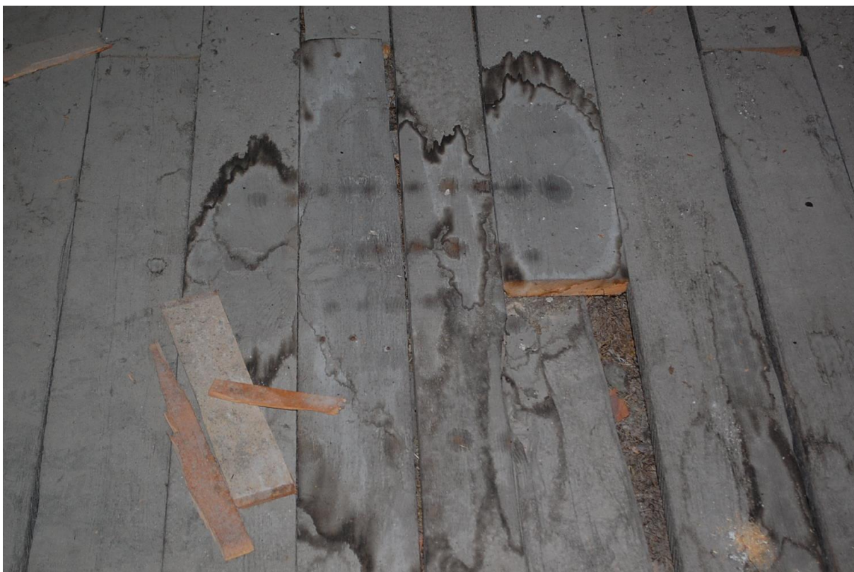
Kuva 34 Tippumisjälkiä laualattialla
