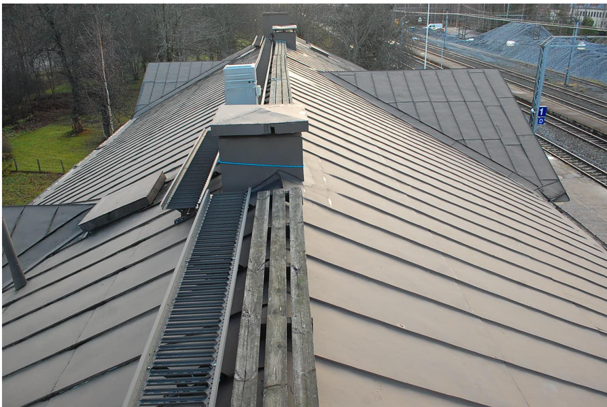
Kuva 29 Kattosillat
