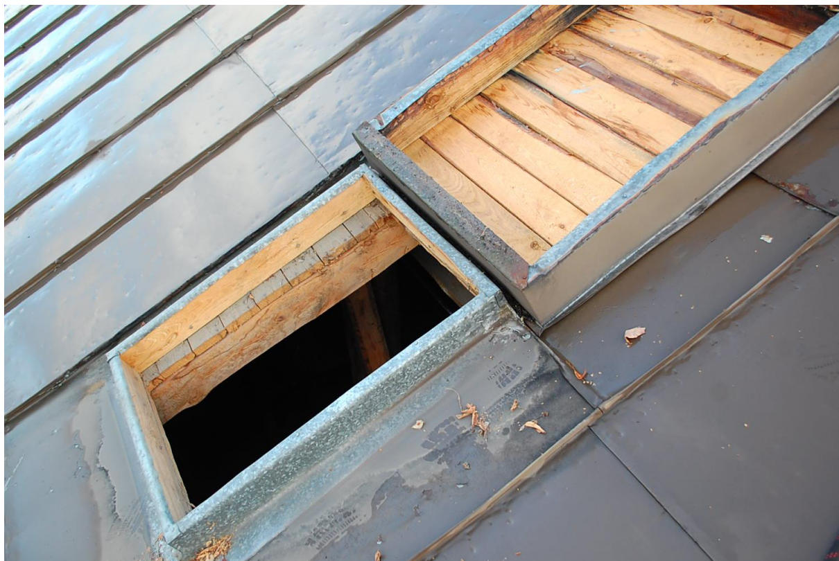
Kuva 23 Putoamisen estävä ketju puuttuu luukusta
