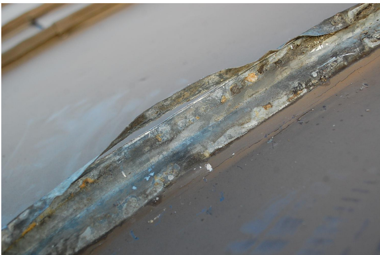
Kuva 2 Tarkastusta varten avattu rivisauma, ratkeama reunassa
