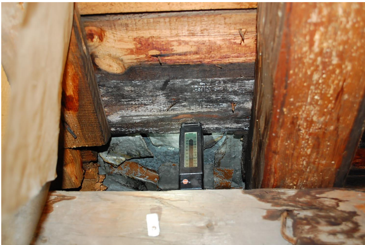
Kuva 9 Lähikuva vuotokohdasta
