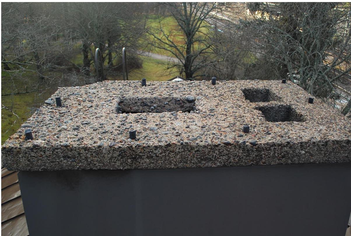
Kuva 25 Sadekatos puuttuu
